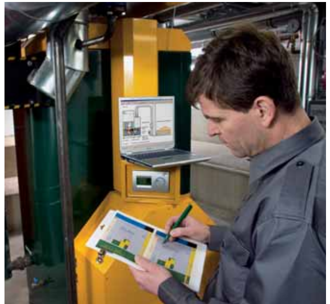
Inbetriebnahme einer Heizungsanlage
