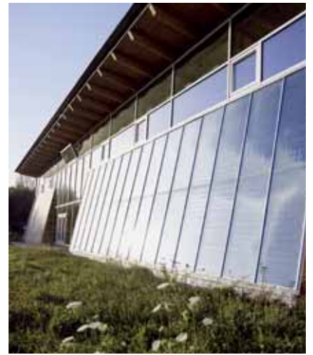
Aufgeständerte Solarkollektoren
